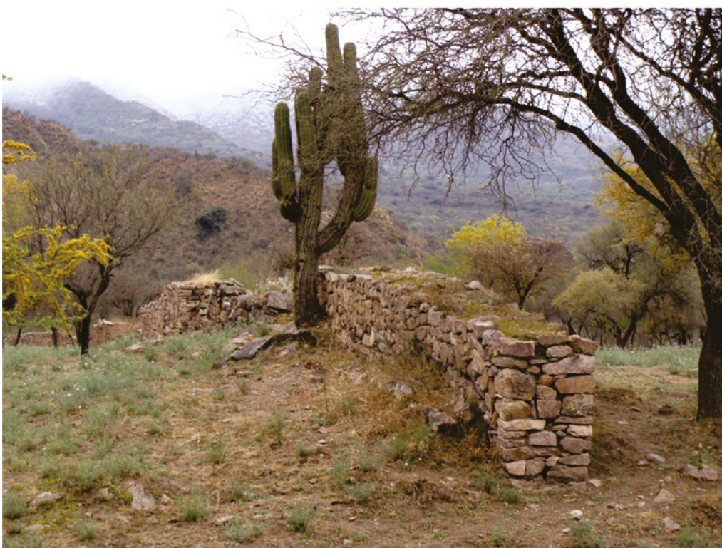
Figura 5. Muro orientado con vanos en la plaza de El Shincal.
