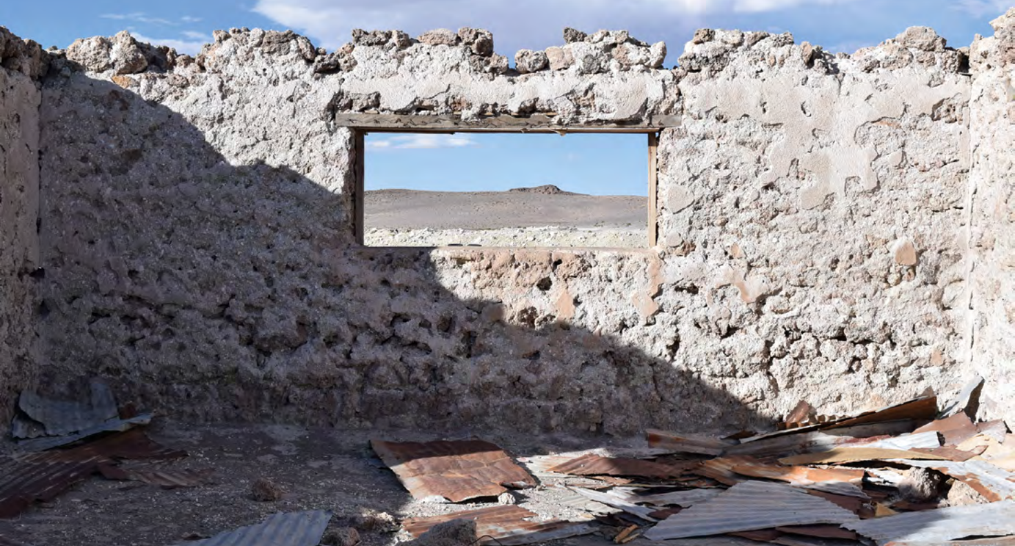
Figura 5. Buenaventura, habitación de trabajadores desmantelada.
