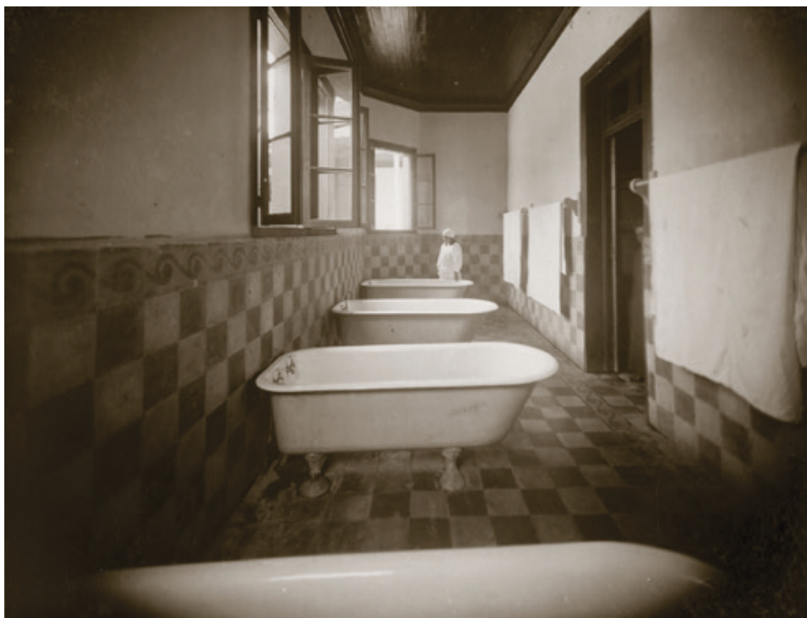
Figura 5. Fotografía baños con baldosas de concreto. Fecha indeterminada, inicios siglo XX.
