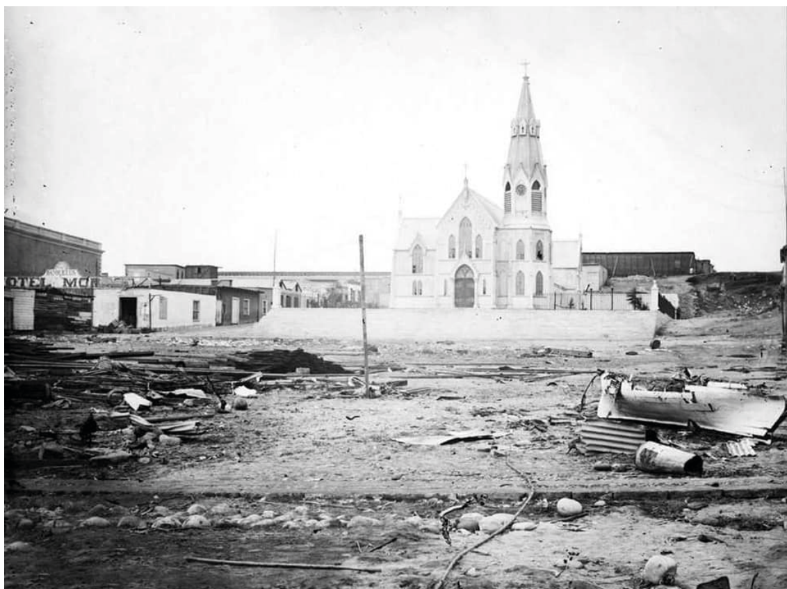
Figura 10. Iglesia San Marcos de Arica tras el impacto del tsunami en agosto de 1868. Fuente: Publicada 09.05.2020 por Cosas Varias Arica en grupo Facebook Ese Arica de Antes.
