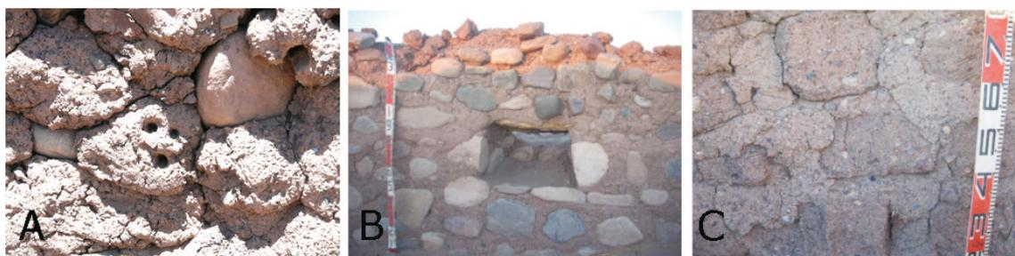
Figura 3. Construcciones de barro no modulares (A), con módulos de piedra (B), y con módulos de barro (C) en Ramaditas.
