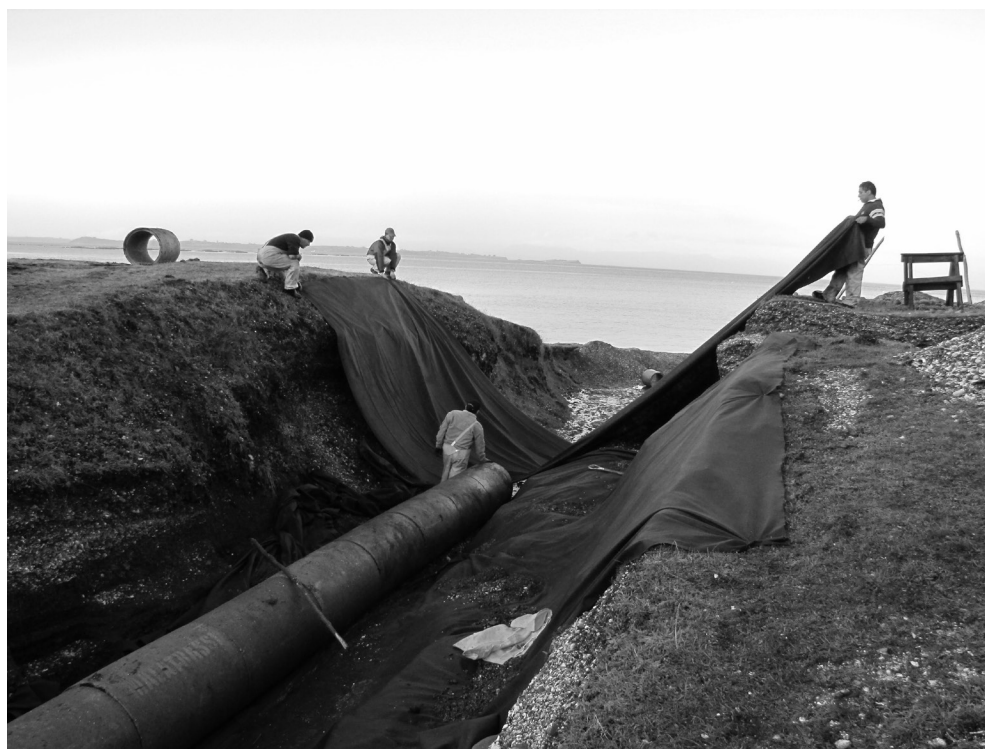
Figura 3. Cobertura con geotextil e instalación de tubería en la zanja de Ilque 1 (Fotografía: Pablo González).
