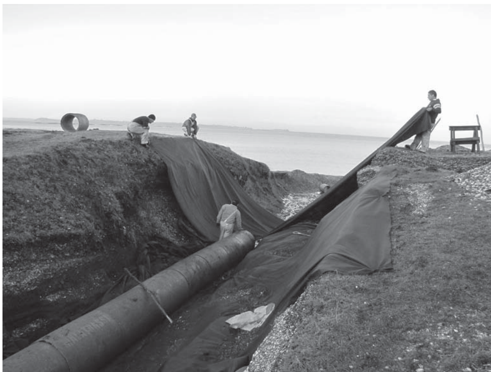
Figura 3. Cobertura con geotextil e instalación de tubería en la zanja de Ilque 1 (Fotografía: Pablo González).
