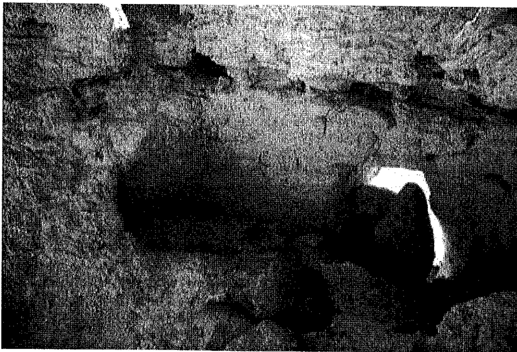
Foto 2: En esta fotografía se observan claramente las cavidades en las que se insertan las lajas del techo de la cámara interior de una Chullpa, marcando la división entre la primera y segunda etapa de construcción.
