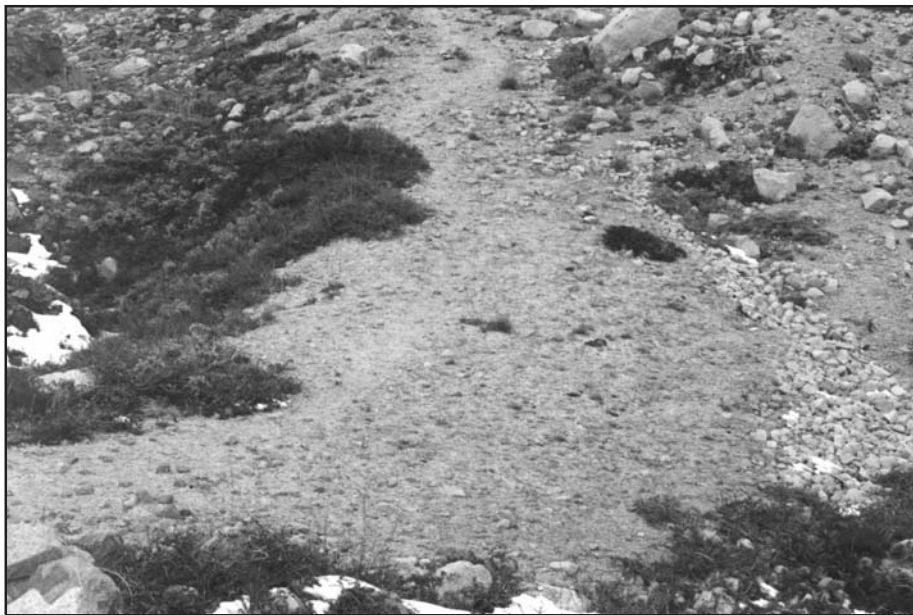
Figura 7. Terraplén sobre una pequeña oquedad del terreno en el tramo Norte del camino Inka.
